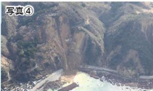
国道249号法面崩落
