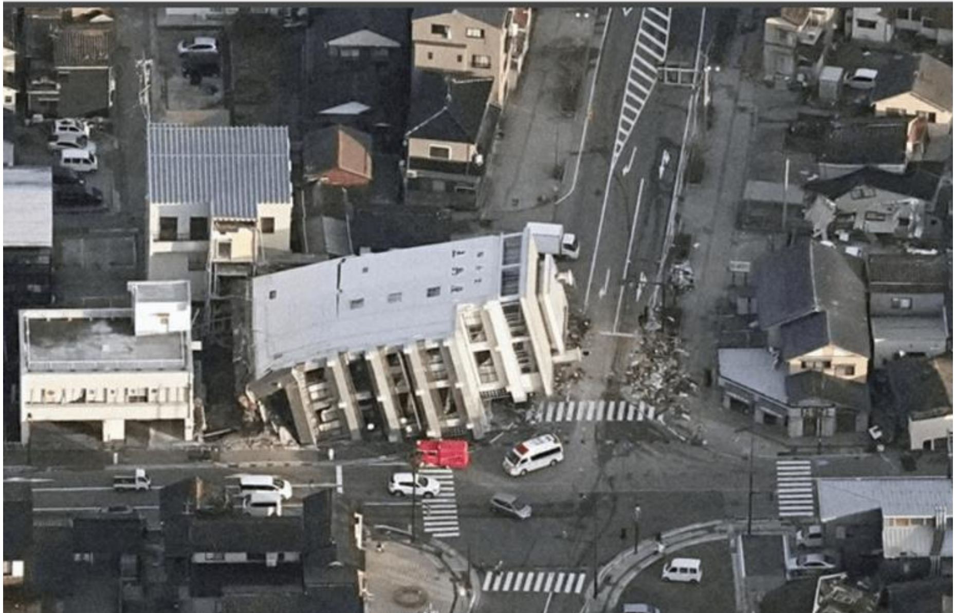
輪島市 震度6強 7階建てビルが根元から横倒し(甲263、甲264)
