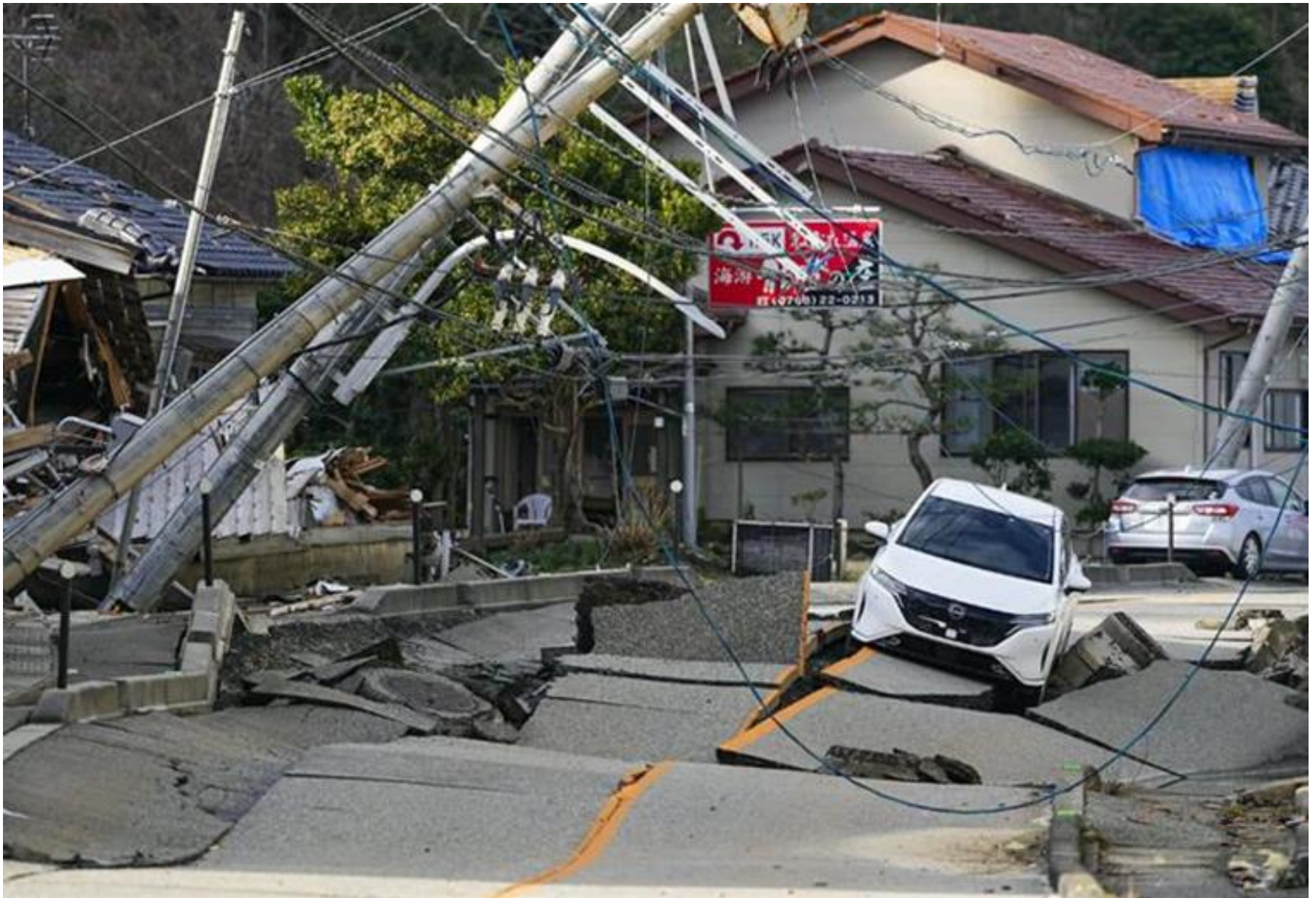
輪島市 国道247号線 (甲262)
