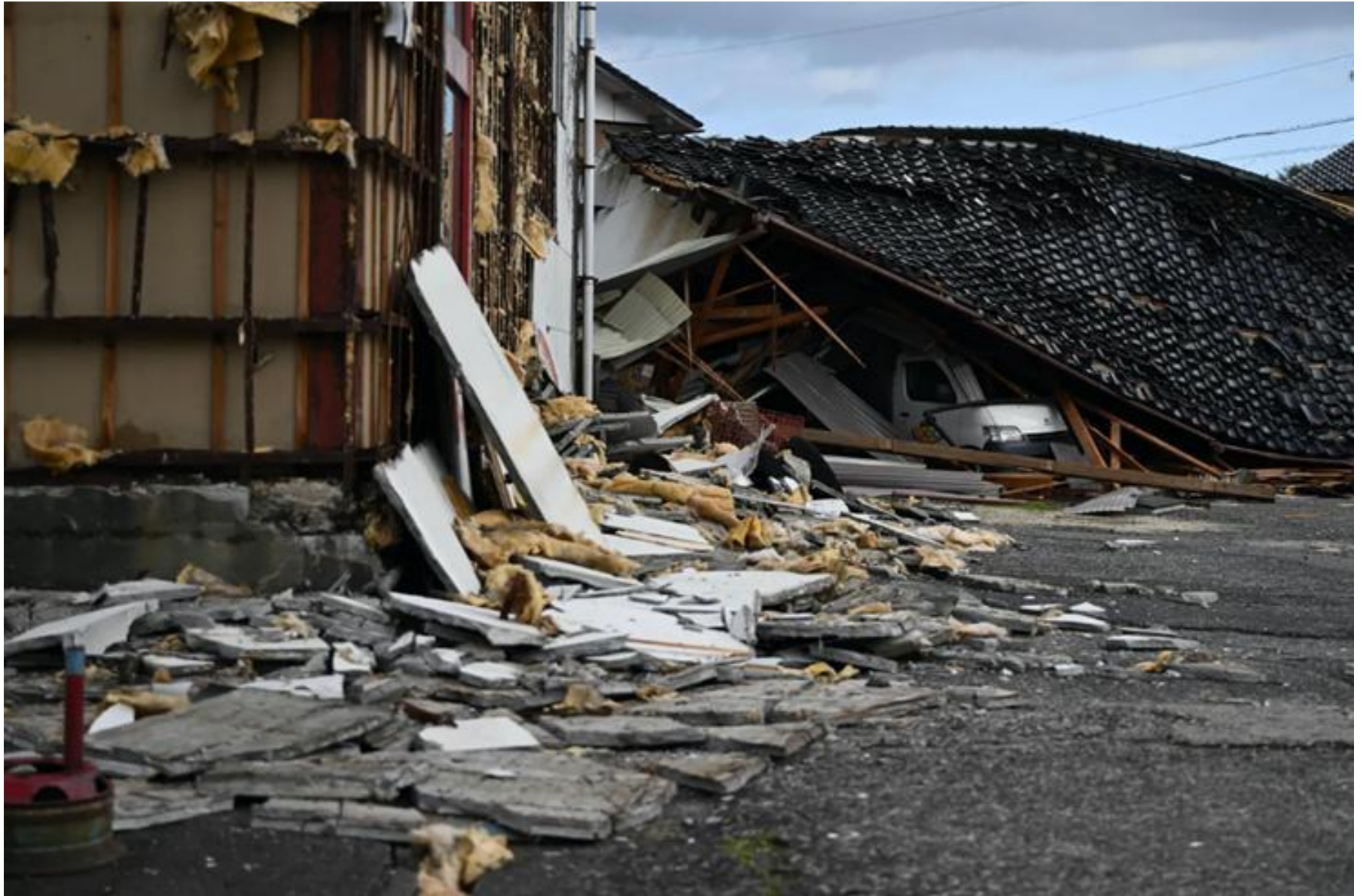
穴水町 震度6強 被害棟数2063棟(1月29日時点)(甲273)
