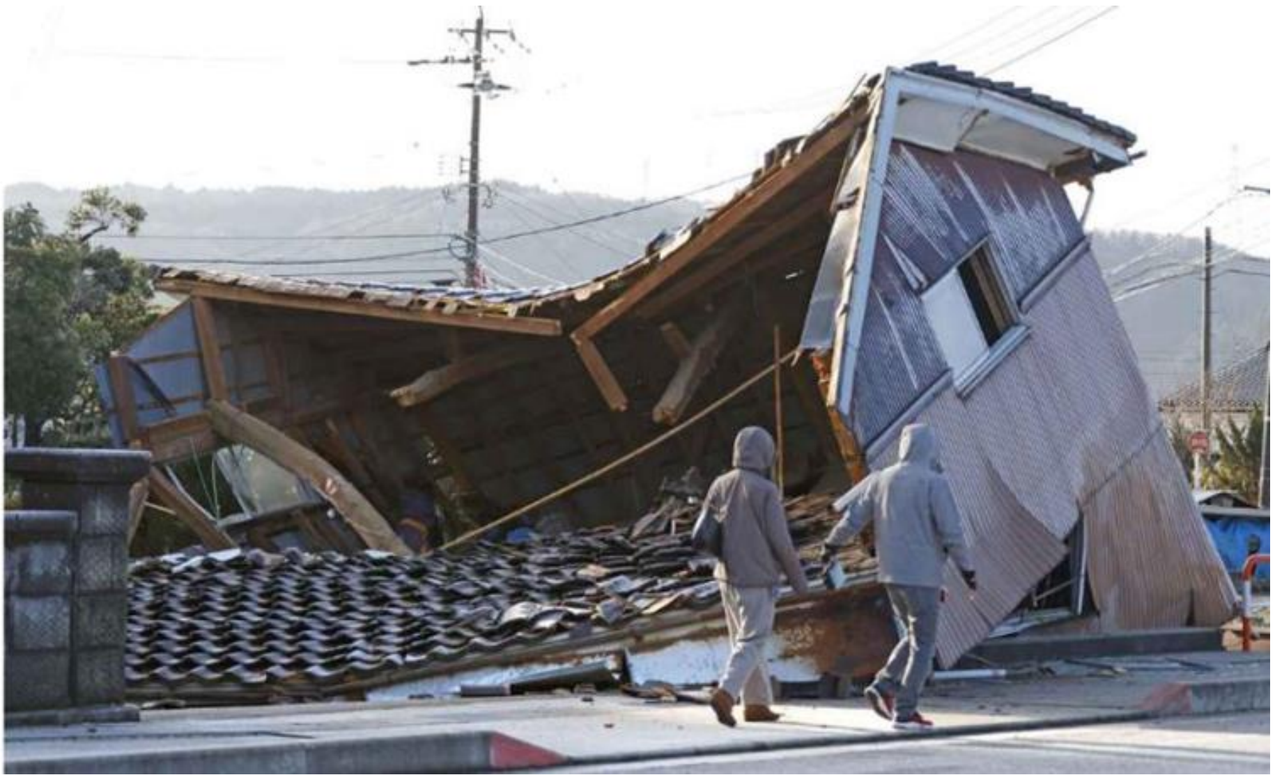
志賀町 震度7 被害棟数4535棟(1月29日時点) (甲261、甲273)。
